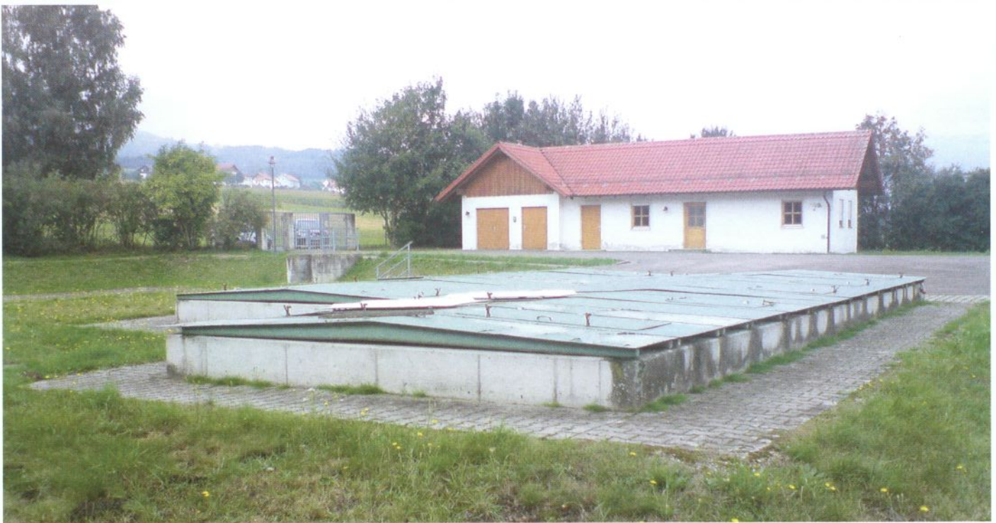
GEMEINDE GLEISSENBERG: Kläranlage für 1800 Einwohner vor dem Umbau.
